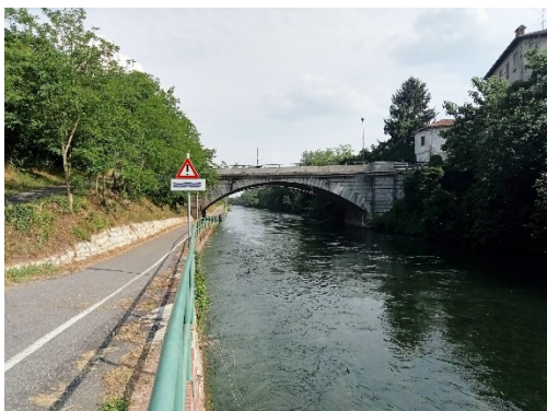
Ponte Nuovo di Magenta su Naviglio Grande
