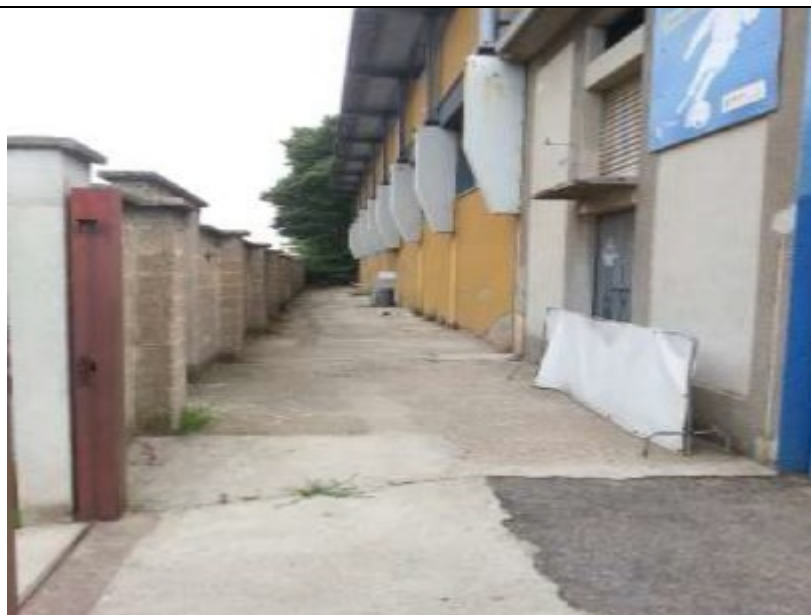
Corsello accesso spogliatoi
