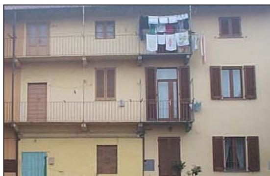
Tipologia a ballatoio: finestre a due battenti, semplici e inserite regolarmente in facciata
